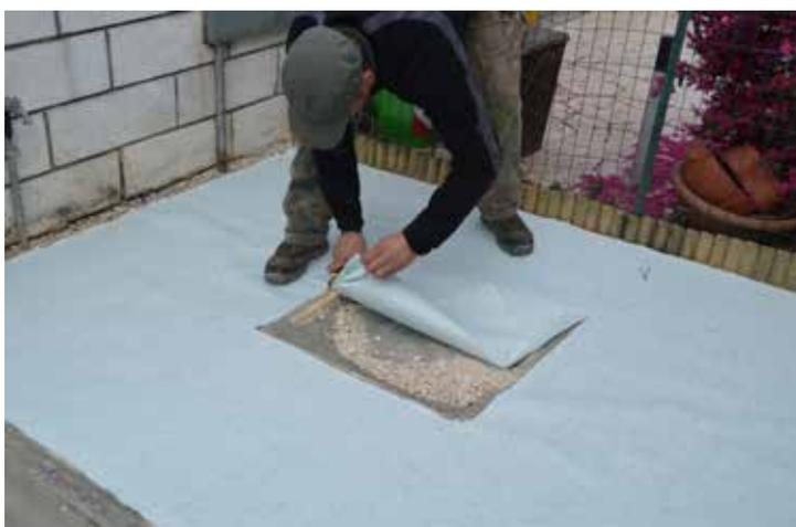
Nel caso di ostacoli all'interno dell'area, come i pozzetti di derivazione, togliere il materiale in eccesso e fissare i perimetri con la graffettatrice.
