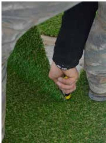
Tagliare la parte di prato che ricopre il pozzetto con precisione, ed incollarla con del nastro biadesivo al coperchio del pozzetto.
