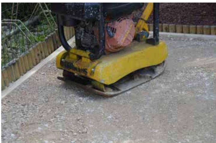
Dopo aver livellato lo stabilizzato compattarlo con un compattatore vibrante a motore, stando attenti a non andare sopra al perimetro di stanghetti in legno.
