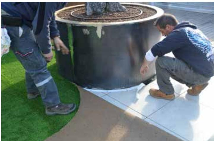
Anche per il perimetro degli ostacoli all'interno dell'area di posa si dovrà procedere con la stesura del nastro biadesivo come spiegato precedentemente.
