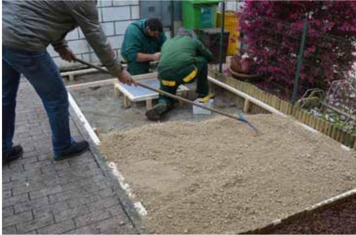
Una volta ultimato il perimetro, si procederà al riempimento dell'area con dello stabilizzato e la successiva stesura uniforme, facendo attenzione a riempire tutti gli spazi anche sotto al perimetro in legno.
