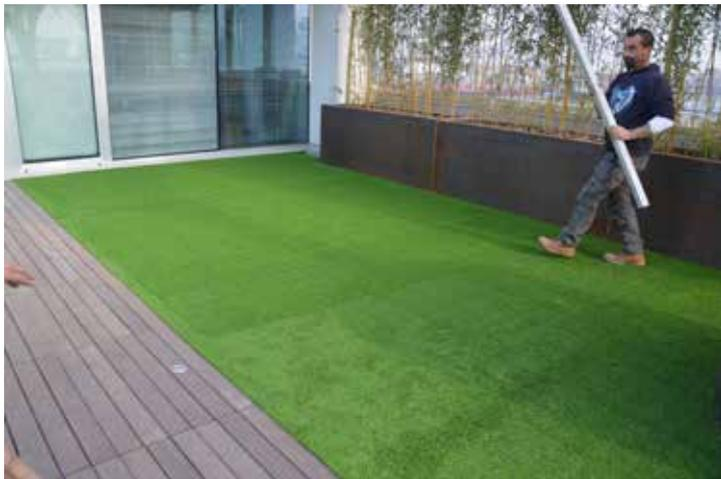
Una volta completata l'area di posa da ricoprire con il prato sintetico, verificare che la superficie risulti omogenea e che le unioni delle varie strisce di prato non siano visibili.
