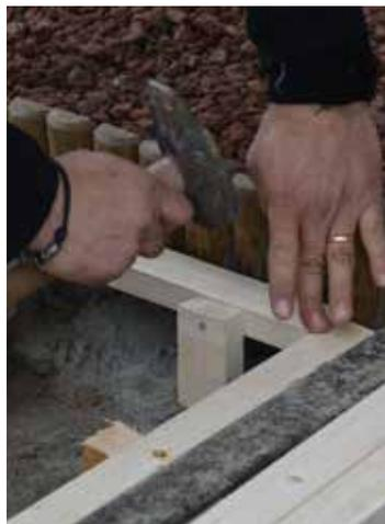
Fissare i picchetti agli stanghetti con dei chiodi di lunghezza idonea, oppure usare delle viti da legno ed un avvitatore elettrico.
