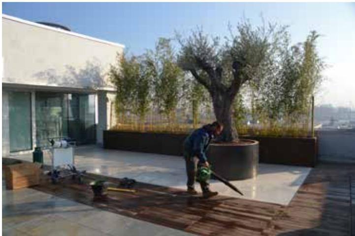
Pulire da polvere e possibili residui l'area interessata per la posa del prato sintetico, utilizzando un soffiatore a motore.
