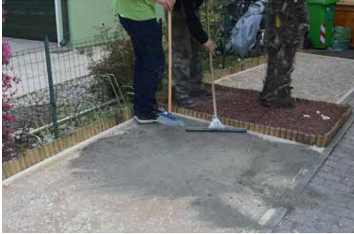
Sopra allo stabilizzato compattato stendere uno strato sottile e uniforme di sabbia silicea Ø 0,6-1,2 mm.
