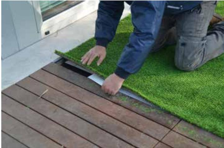
Ora si può passare a togliere la carta di protezione superiore del nastro biadesivo, precedentemente fissato perimetralmente all'area di posa.
