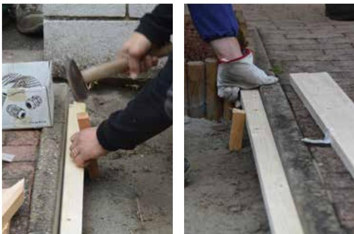
Disporre gli stanghetti lungo il perimetro dell'area di posa, avendo cura di posizionarli ad una quota inferiore di 2 cm da quella della pavimentazione esistente.
