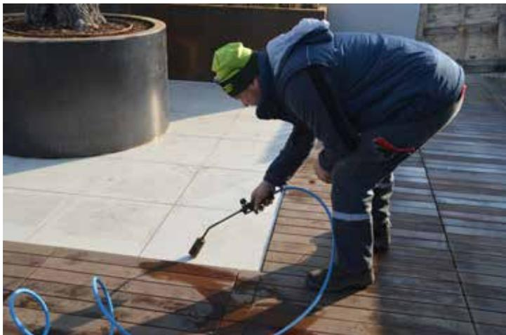
Nel caso la pavimentazione possa risultare umida dalla brina notturna, si consiglia di asciugarla con degli strofinacci e con un cannello a gas, per renderla completamente asciutta.
