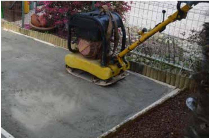
Usare il compattatore vibrante per compattare lo stabilizzato e la sabbia insieme.
