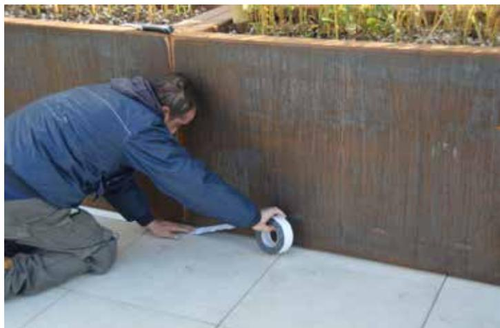
Applicare il nastro biadesivo lungo il perimetro dell'area dove si deve installare il prato sintetico, avendo cura di controllare che la superficie di presa sia perfettamente asciutta.
