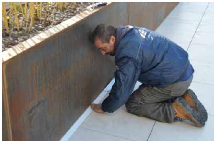
Il nastro biadesivo deve aderire completamente alla pavimentazione; per aiutare l'operazione, fare leggera pressione con le mani sulla parte superiore per verificare la perfetta adesione.
